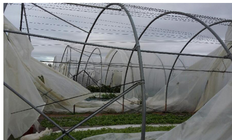
Serres après le passage de la tempête
