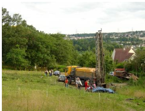
JUIN 2007 FORAGE D'UN Puits A VERRIERES Au « Champ bleu » de Lionel, l'installation de l'eau a été bien plus épique que prévu... Un forage très profond a été nécessaire... installation de Lionel en cours...
