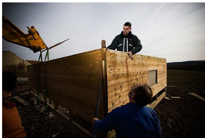
Remontage de la 1 ère cabane
